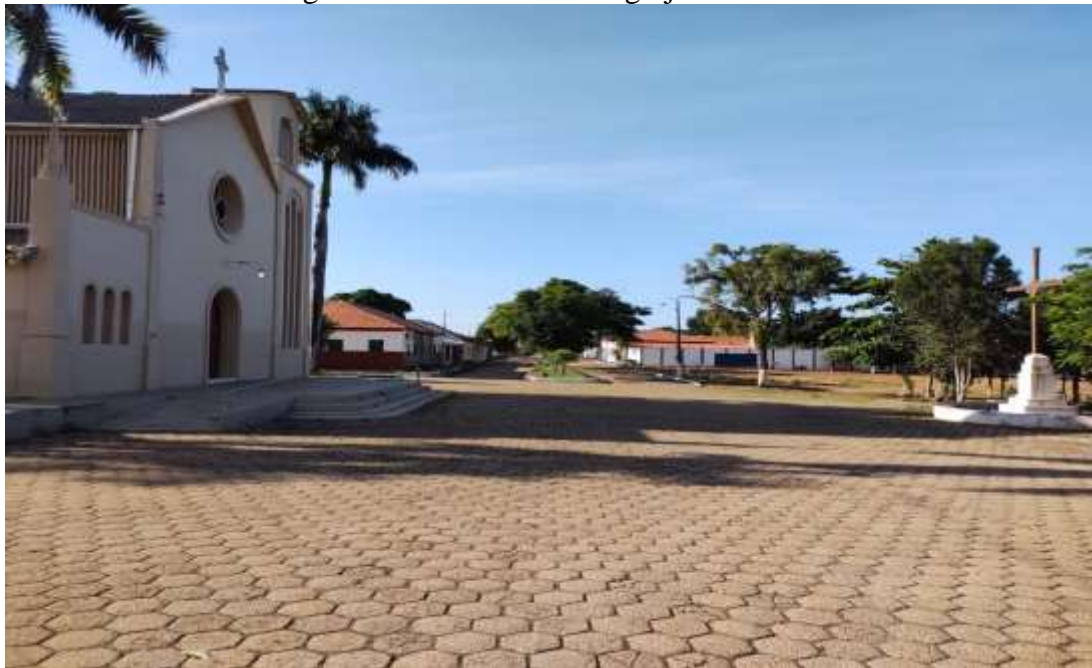
Figura 2 – Frente da atual Igreja São Pedro
